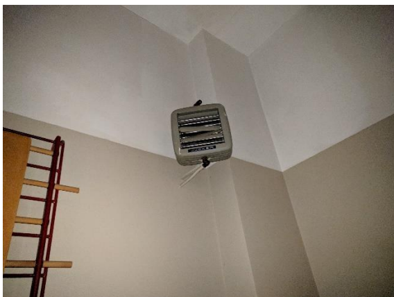
Figura 4.7 – Particolare areotermi
