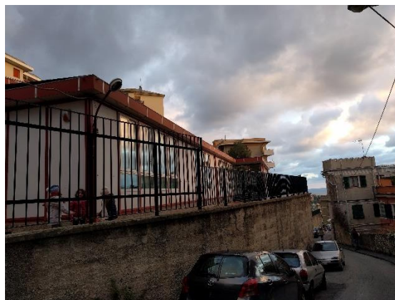
Figura 1.1 - Vista della facciata Sud
