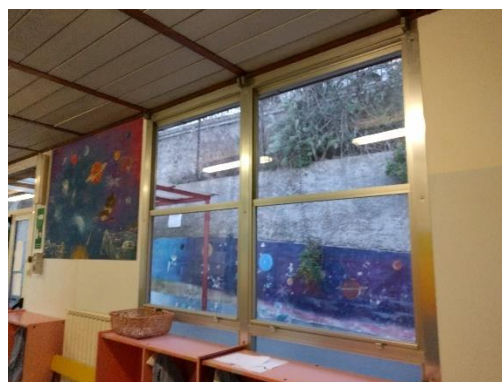
Figura 4.4 - Particolare dei serramenti in alluminio e vetro singolo
