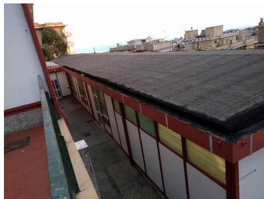
Figura 4.2 - Particolare della facciata
